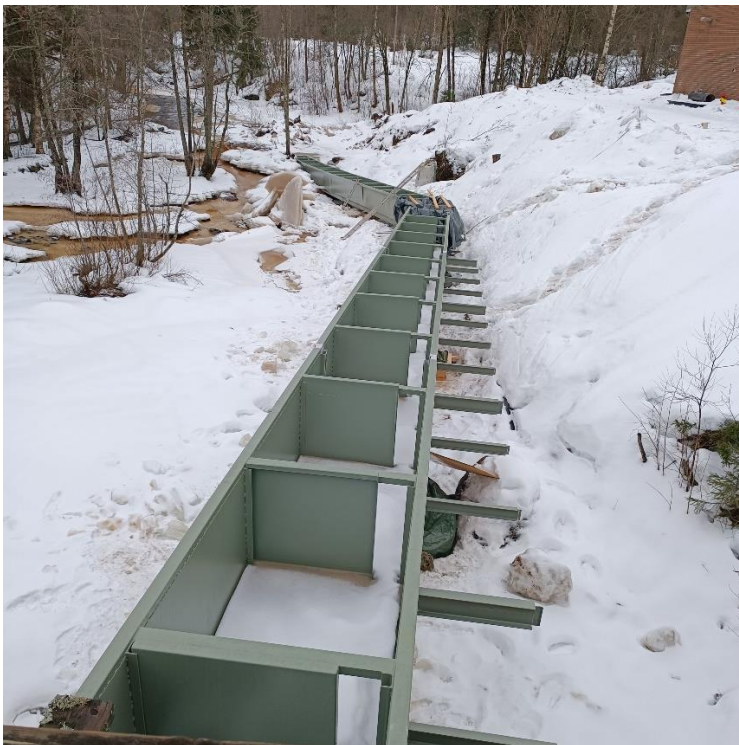
Kuva 3. Kuva rakenteilla olevasta kalatiestä helmikuussa 2024.
