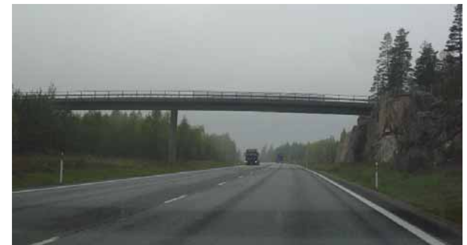
Kuva 7.1. Sillat on rakennettu valmiiksi kaksiajorataista tietä varten. Muualla kalliroleikkaukset laajennetaan tulevan tarpeen mukaan.
