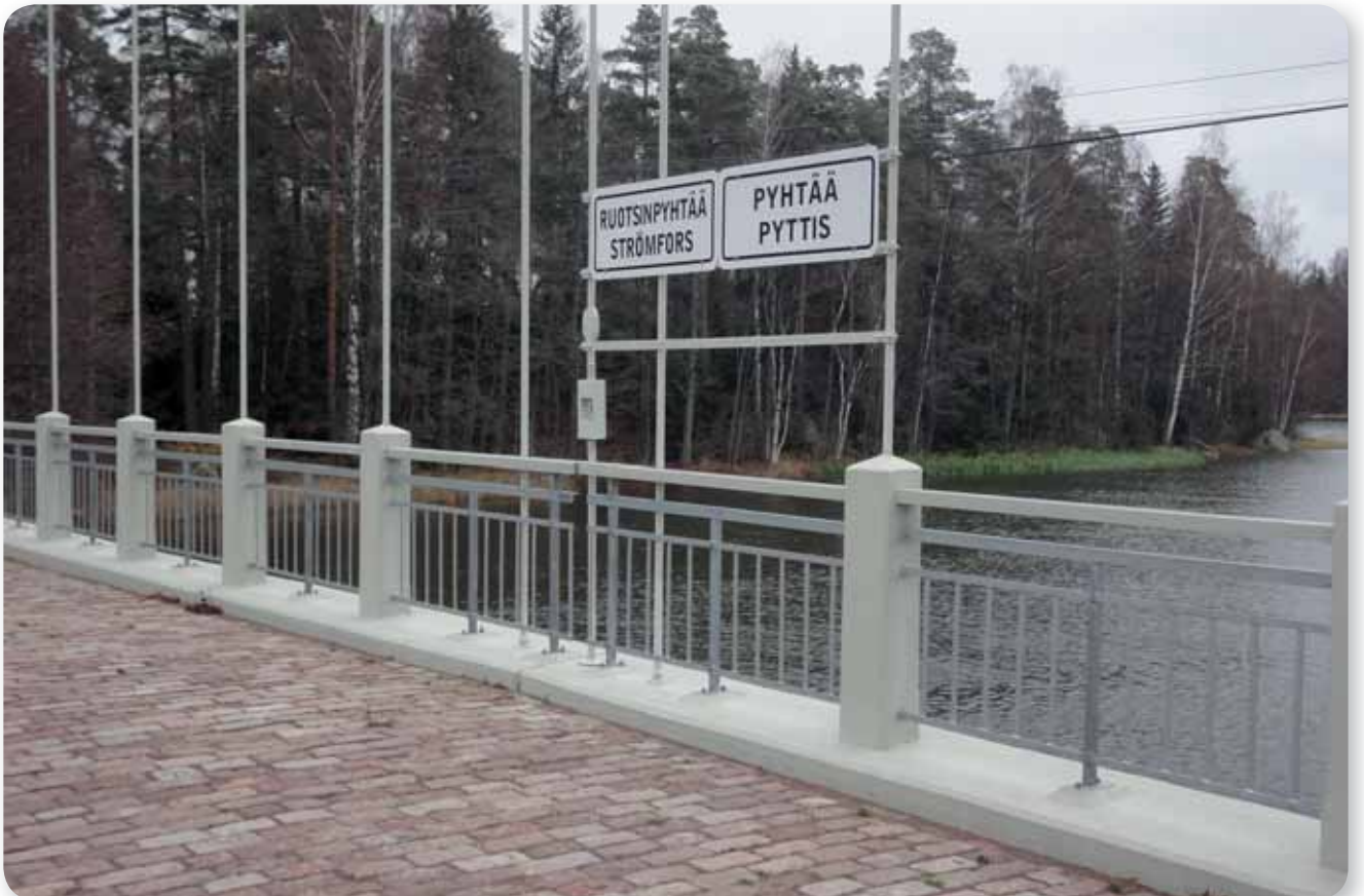
Kuva 1. Vanha raja on merkitty sillalle. Kuva Martti Piltz.
