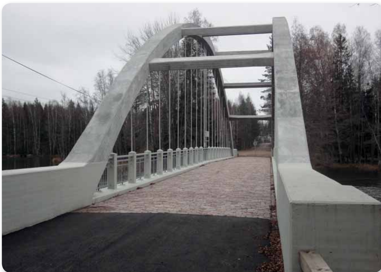
Kuva 24. Savukosken silta on ulkomuodoltaan alkuperäistä muistuttavassa kunnossa. Todennäköisesti sillan museaalinen ikä on vuosikymmeniä. Silta on olennainen osa sekä ympäröivää maisemaa että rakennettua kulttuuriympäristöä. Kuva Martti Piltz.
