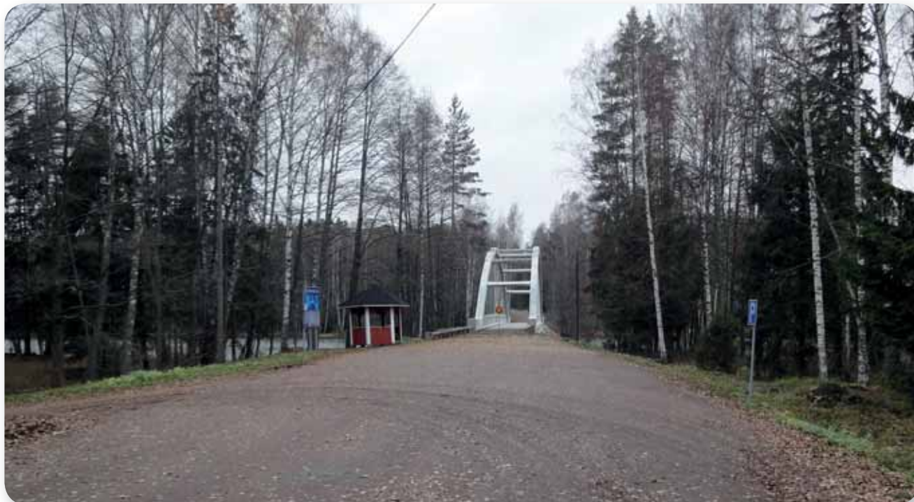
Kuva 17. Siltapaikka etelästä katsoen. Kuva Martti Piltz.
