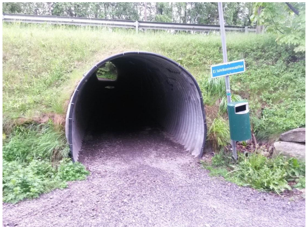
Kuva 5. Toosin nykyinen alikulkukäytävä
