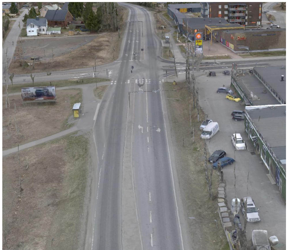
Kuva 3. Liittymäalue idästä päin
