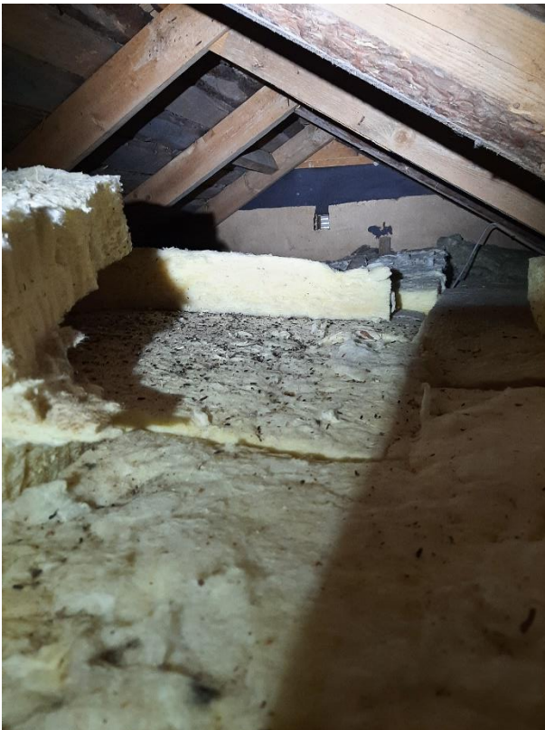
Kuvat 3 ja 4. Lepakoiden ulosteita yläpohjassa. Ulostetta on tasaisesti eri puolilla yläpohjaa eristevillan päällä ja muurin juurella.
